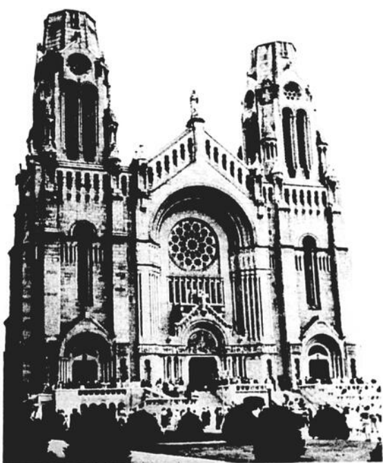
La basilique dédiée à sainte Anne n'est pas encore terminée. Elle le sera d'ici trois ou quatre ans.
