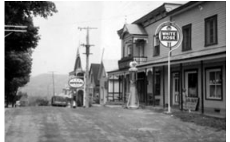
À gauche, le premier système d'électrification : un fil, une porcelaine par maison. À droite, poteau plus haut avec un transformateur et un fil de 25 kV. Vers 1944.
