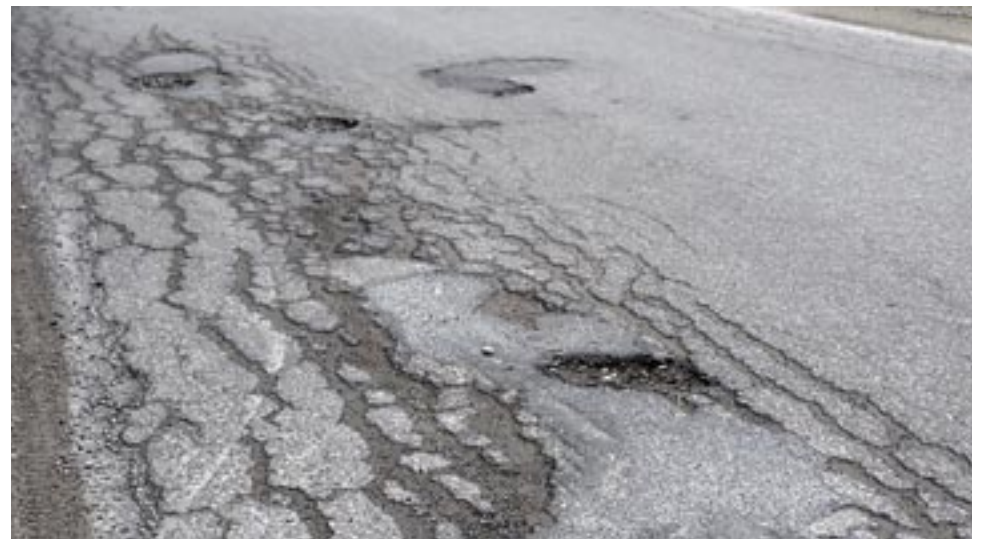
Des nids de poule qui apparaissent tous les ans à la suite du gel et du dégel.
