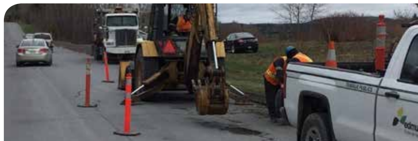
Le conseil municipal d'Edmundston a octroyé cinq contrats importants qui permettront d'améliorer les infrastructures et installations municipales. Photo contribution
