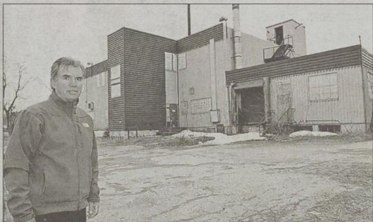
Le conseiller Claude Tremblay a toujours l'intention de faire disparaître l'immeuble qui abritait l'ex-Boulangerie Fortin, mais Saguenay aura besoin de 100 000 $ pour les travaux de démolition.
