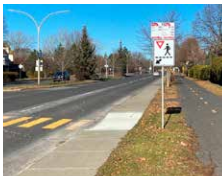
Traverse piétonne avec correction de trottoir. Sur le boul. Seigneurial/ intersection Dunant
