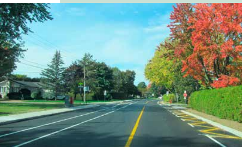
Reconstruction des infrastructures rue De Rigaud
