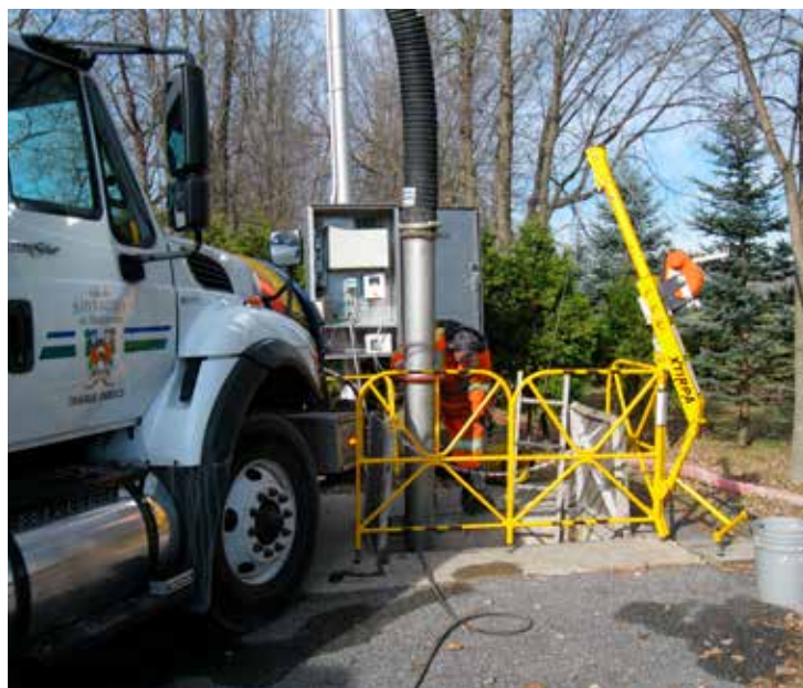
Nettoyage d'un égout sanitaire avec camion Vactor et descente en espace clos selon des procédures sécuritaires
