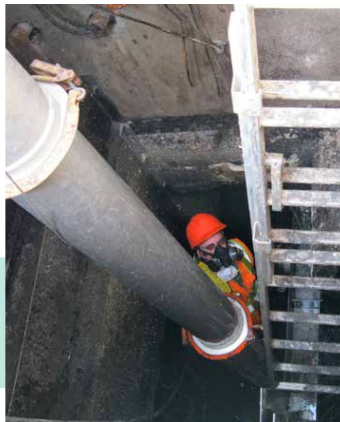
Nettoyage d'un égout sanitaire avec camion Vactor et descente en espace clos selon des procédures sécuritaires
