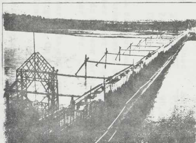
Fig. 12 Barrage à claire-voie en tiges de fer dit "Outchoug", installé près d'Ouralsk pour arrêter les esturgeons dans leur migration. (D'après Khorochkhin.)
