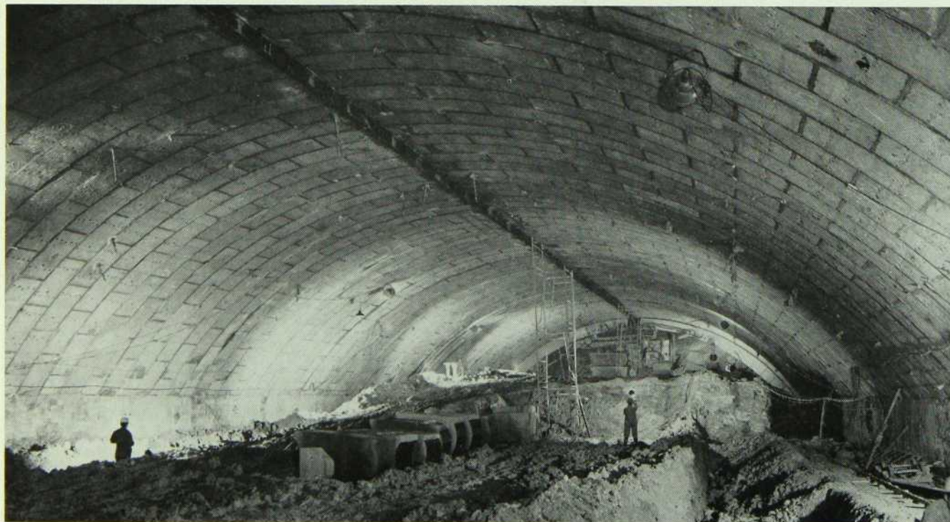
Station « Nation » — longueur : 225 m largeur : 25 m La construction de cette station progresse à la cadence de 0,80 m par jour ; la voûte et les culées doivent être terminées à l'automne 1967.
