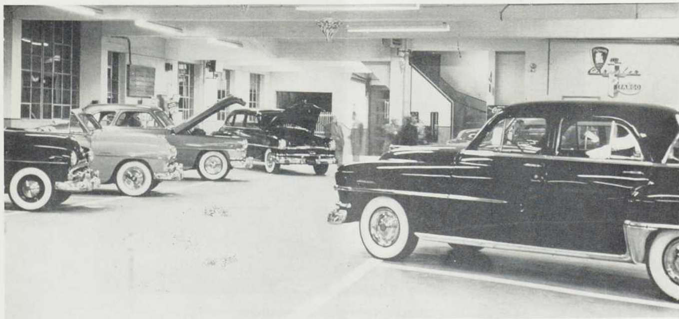
LE PREMIER PLANCHER DU GARAGE DONNANT SUR LE MONTE-CHARGE
