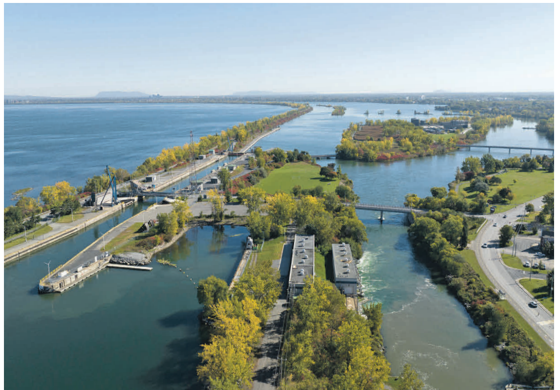
Écluse Sainte-Catherine sur la Voie maritime du Saint-Laurent, près de Montréal. PHOTO: CORPORATION DE GESTION DE LA VOIE MARITIME DU SAINT-LAURENT.
