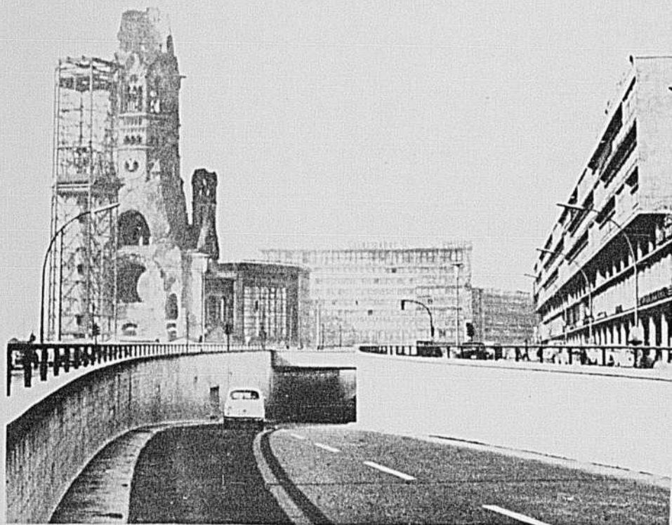
Nombreux viaducs Les ingénieurs de Berlin-Ouest ont construit plusieurs viaducs comme celui-ci, afin de décongestionner les artères achalandées de la capitale. À l'arrière-plan, on aperçoit l'une des plus célèbres églises de Berlin, la Gedachtniskirche. Comme elle avait été presque entièrement détruite par les bombes alliées, il a été pendant un certain temps question de la faire disparaître tout à fait, mais on a enfin décidé d'en refaire ce qu'elle était depuis toujours, l'un des plus beaux monuments de la ville.
