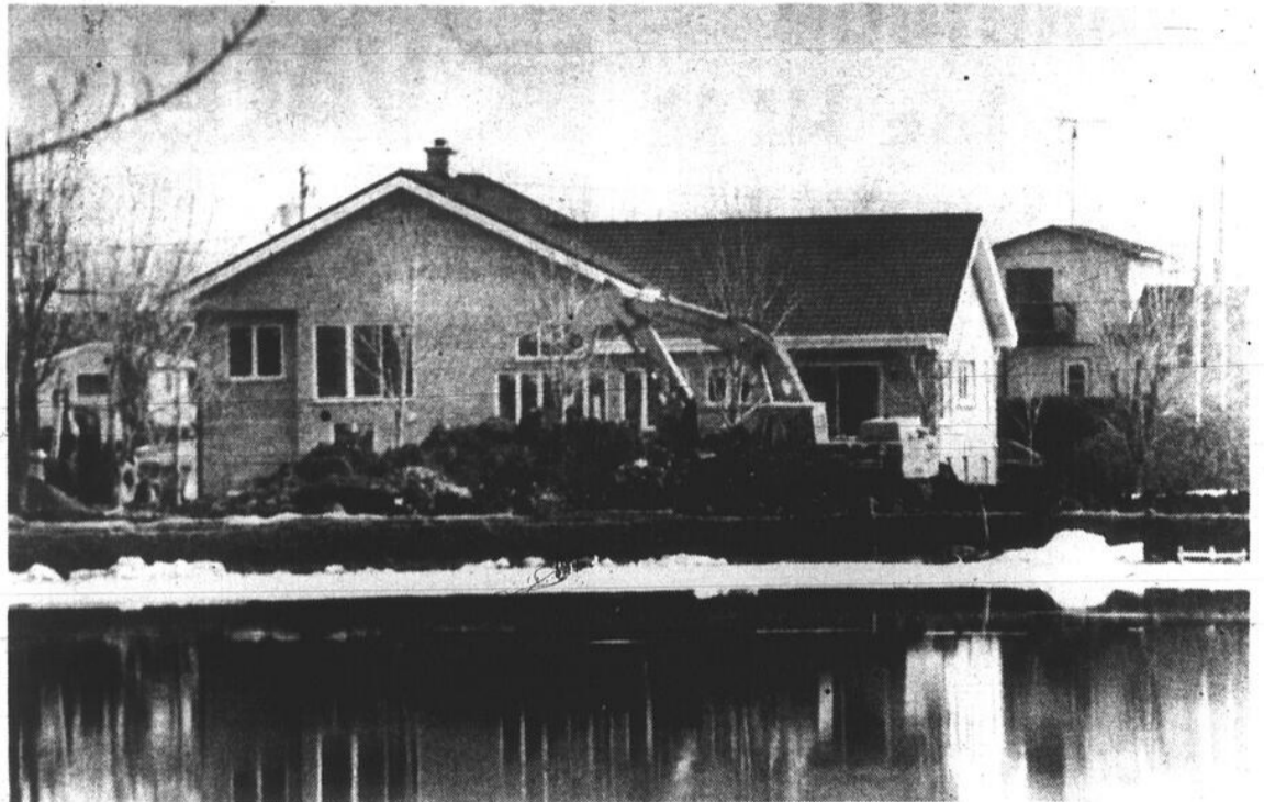
Les travaux ont été complétés le 12 mars, avant la période de dégel.
