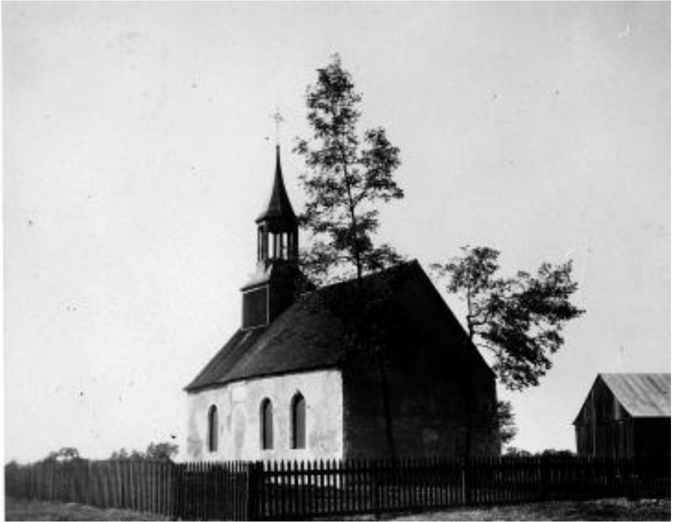
Vue est de la chapelle Cuthbert après les réparations, Berthier, QC, 1928. Anonyme – Anonymous. 1928, 20e siècle. MP-0000.1522.4
