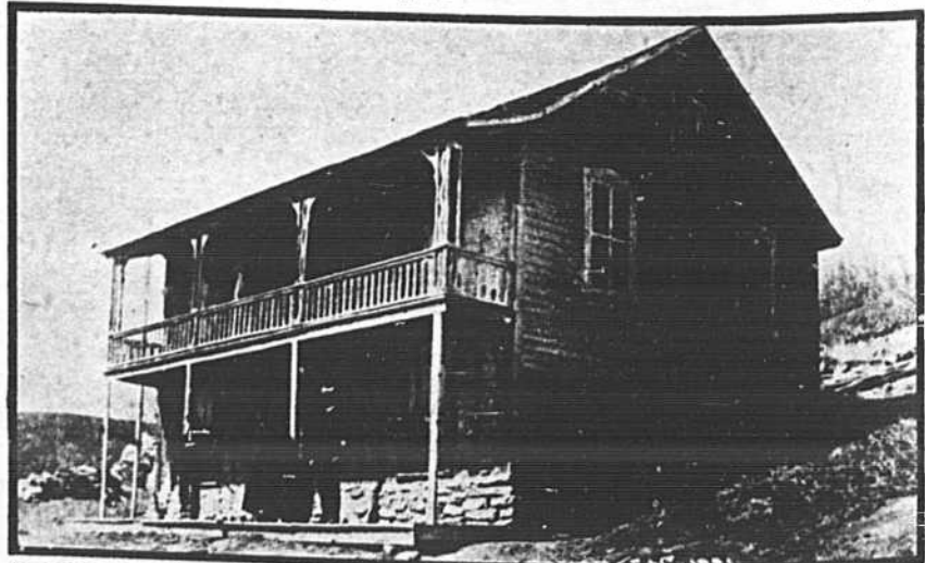
La maison que Jean-Louis Légaré se fit construire à Willow Bunch en 1881.
