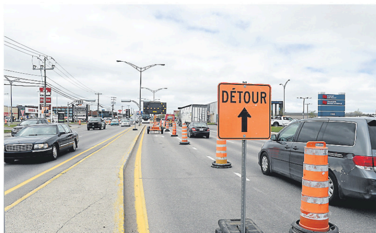
Les travaux sur le boulevard Talbot entraînent la fermeture de la voie lente en direction nord, entre les rues des Saguenéens et des Champs-Élysées. — PHOTO LE QUOTIDIEN, JEANNOT LÉVESQUE
