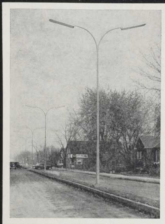
ÉCLAIRAGE DU BOULEVARD CHURCHILL, GREENFIELD PARK, P.O.
