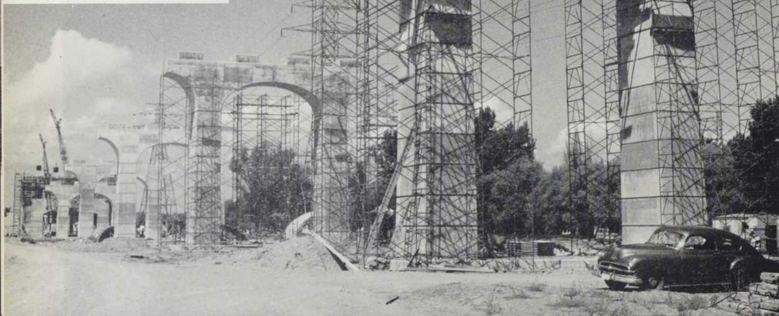
L'AUTOROUTE BURLINGTON BEACH SKYWAY , à Hamilton, Ontario. Ministère de la Voirie de l'Ontario. Exécution des plans et surveillance des travaux : Foundation of Canada Engineering Corp. Ltd., Toronto. Architecte : William R. Souther & Associates, Hamilton. Entrepreneur : Pigott Construction Co. Ltd., Hamilton.
