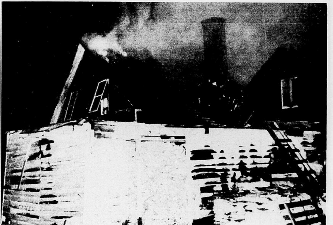
INCENDIE A JERSEY MILLS — Cette photographie vous laisse voir la résidence de M. Odilon Paquet, de Jersey Mills, alors que les flammes détruisaient le second étage, la semaine dernière. La brigade de St-Georges, sous la direction de M. Ernest Gilbert, travailla quelque deux heures avant de maîtriser ce feu. Il semble que l'origine du feu soit un court-circuit. (Photo Rosaire Gamache)
