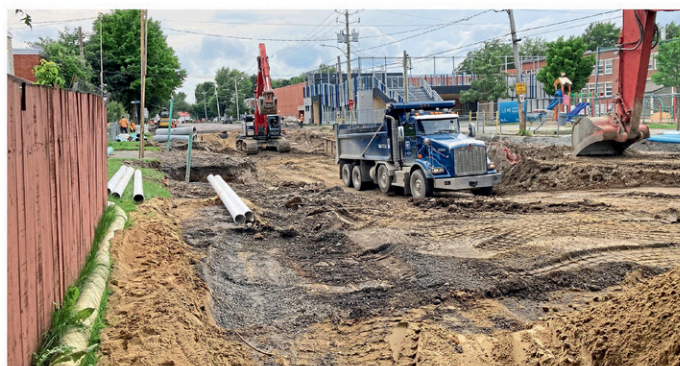
Vue du chantier sur la rue Gagnon (Photo www.lanouvelle.net)
