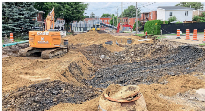
Travaux en cours dans la rue Houle (Photo www.lanouvelle.net)
