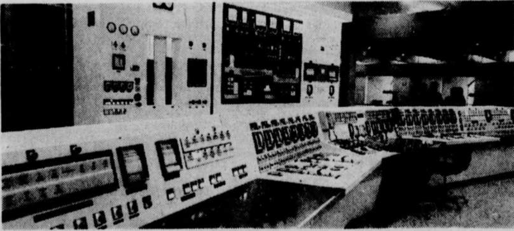
Le quartier Neufchâtel pourra dorénavant profiter d'une eau claire et limpide. En effet, on a inauguré officiellement hier les stations de pompes Valcartier-Montchâtel et de la Colline du réseau d'aqueduc de Québec. Sur la photo, on aperçoit le centre de contrôle de ces trois stations.
