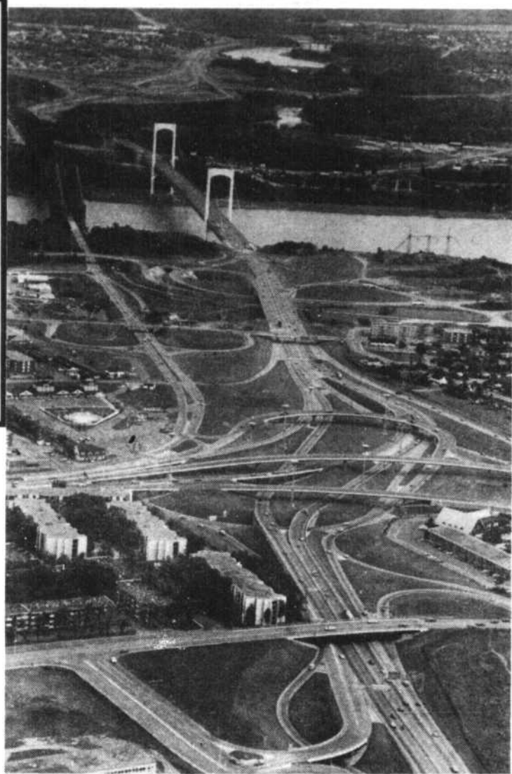
Les ponts et le réseau routier qui y mène constituent le noeud de la circulation à Québec. Obstrués, il s'ensuit des embouteillages monstres.
