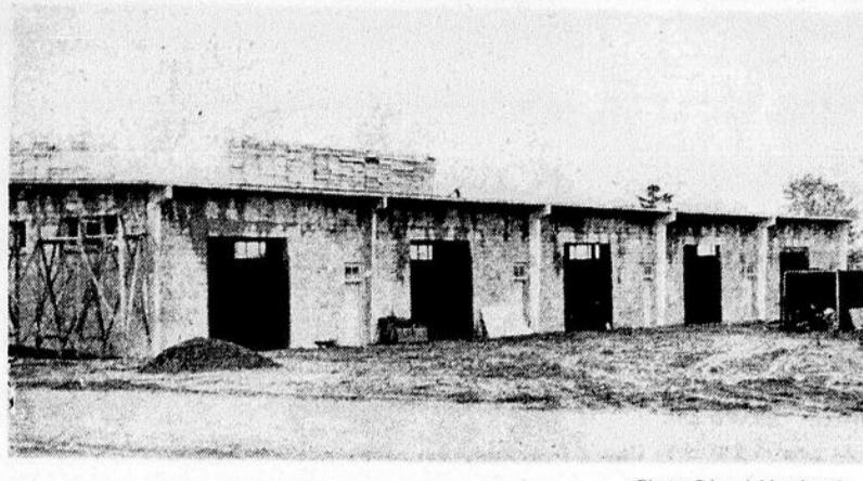
UN ENTREPOT de 160 x 64 pieds, et situé en face du garage municipal de la cité de Grand'Mère, est presque terminé, et servira à entreposer tous les matériaux de construction des services de voirie, d'épandage et d'aqueduc employés par la ville. Cette construction a été exécutée dans le cadre des travaux d'hiver, et il ne reste qu'à compléter la couverture et à y étendre un plancher d'asphalte.
