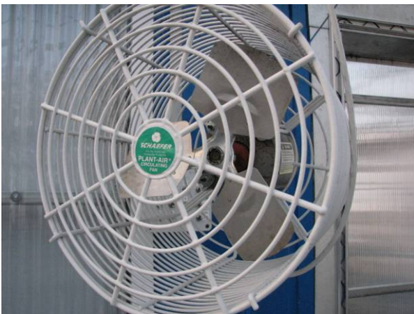
Photo 5 : Pales et grilles de ventilateur horizontal bien nettoyées.
