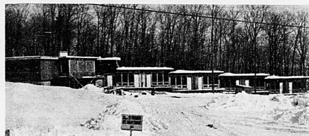
Nouveau motel en construction à la sortie de l'autoroute
