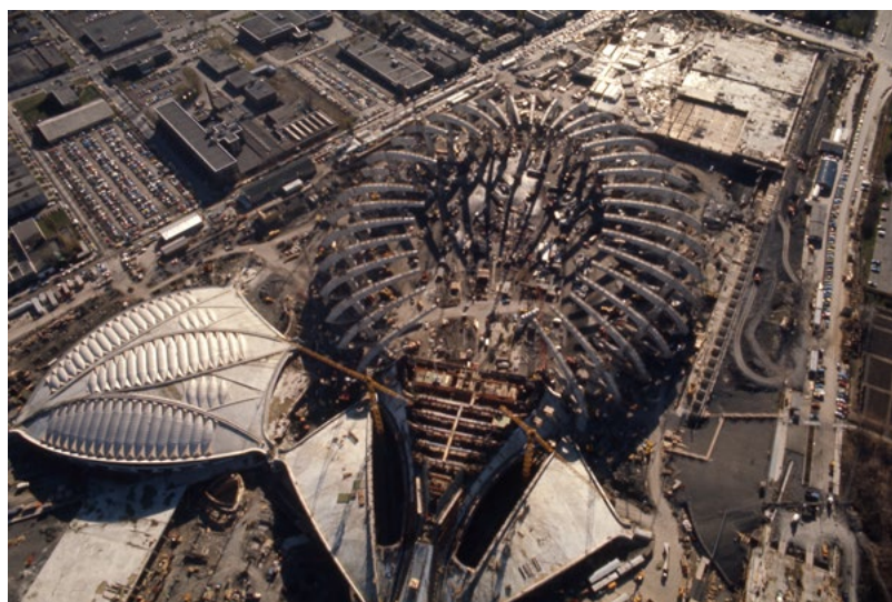
Fig. 27. Le chantier des installations olympiques, le 5 novembre 1975.
