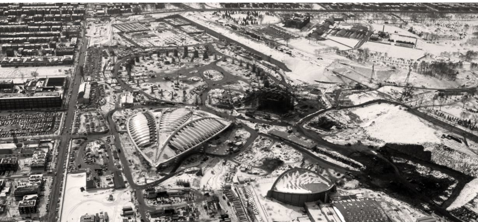
Fig. 25. Le chantier des installations olympiques, le 10 mars 1975.
