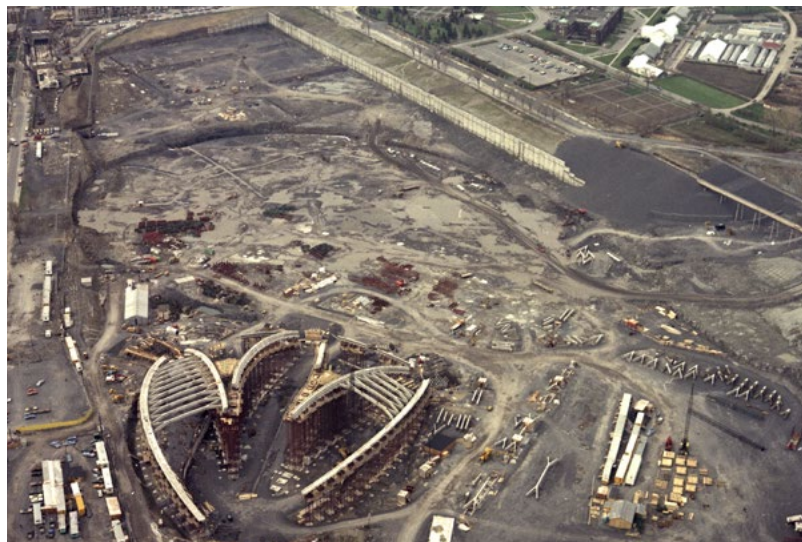
Fig. 24. Le chantier des installations olympiques, le 20 mai 1974.
