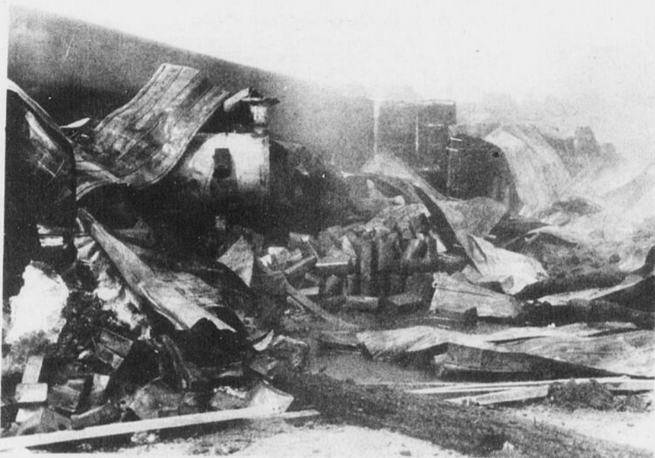
Une partie de l'installation de la distillerie clandestine complètement ravagée. (Photo La Feuille d'Érable - Forand)
