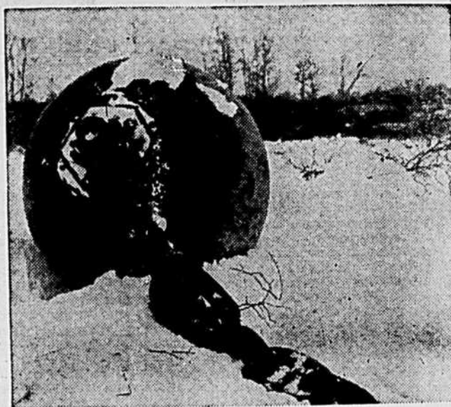
QUILLE NOUVEAU GENRE — Boulet d'acier et chaîne d'ancre utilisés par l'Administration agricole des Prairies pour le débroussaillage des terres. Cette technique a permis à l'Administration d'abaisser le coût du travail à trois dollars l'acre environ sur les grandes étendues.
