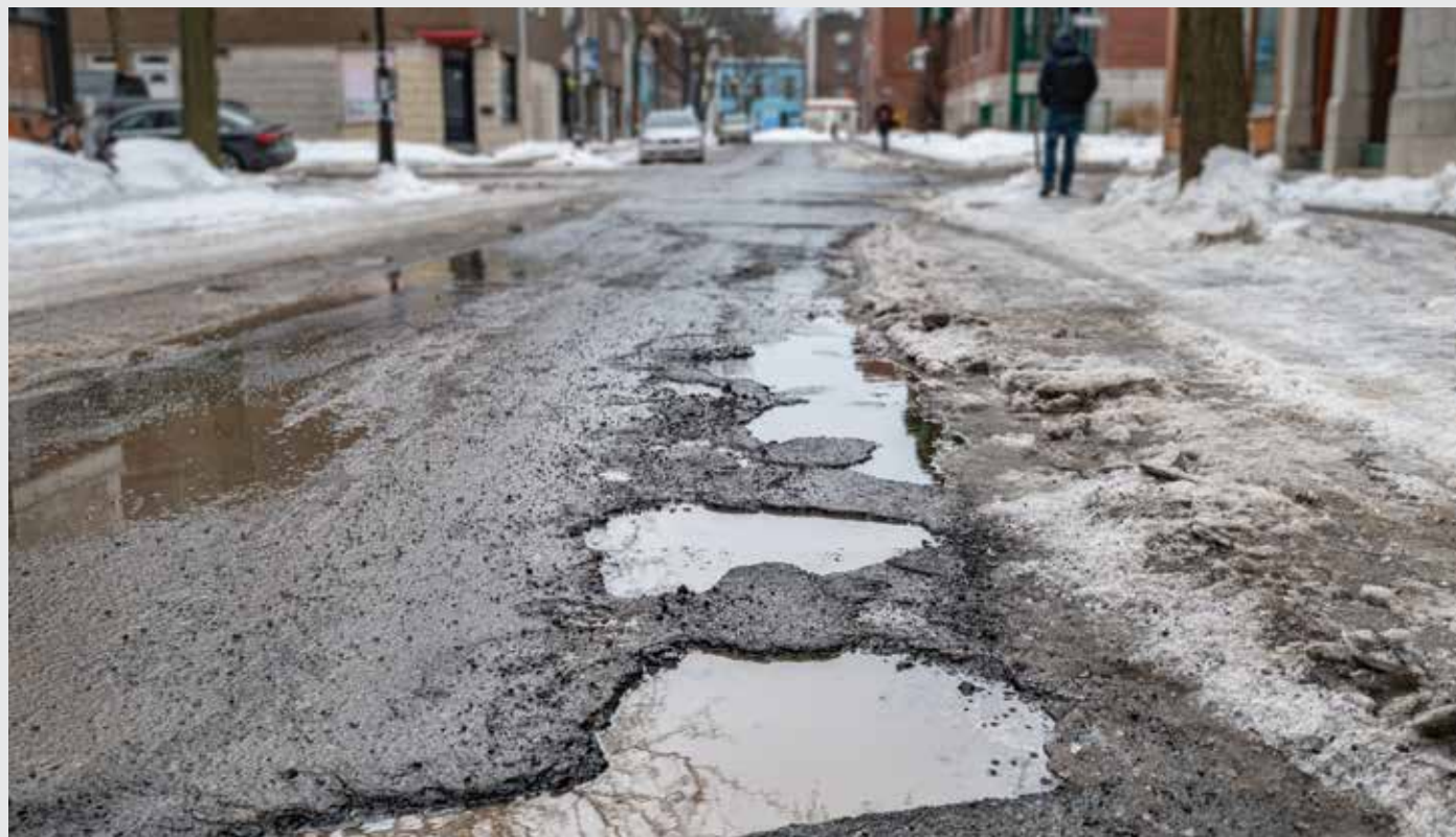
FIGURE 3 LES NIDS-DE-POULE APPARAISSENT SURTOUT AU PRINTEMPS AVEC L'ACTION DES CYCLES DE GEL-DÉGEL
