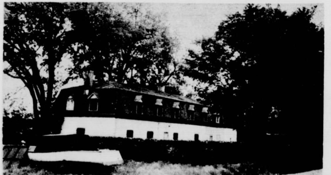
Ce vieux couvent des Petites Filles de Saint-Joseph est situé sur l'ancien emplacement de la maison de Mme d'Argenteuil près de l'église d'Oka.
