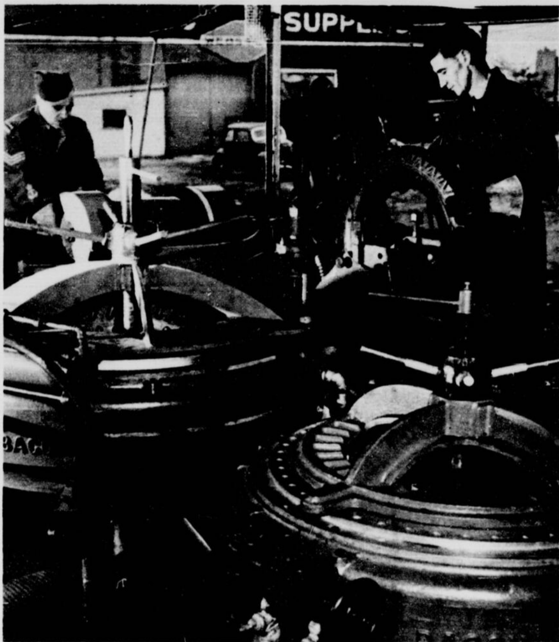
Grâce à un procédé qu'elle a perfectionné elle-même, l'armée canadienne peut rattraper rapidement les pneus et contribuer considérablement à la conservation du caoutchouc. Si l'on tient compte du grand nombre de véhicules de l'armée, l'économie ainsi réalisée est énorme. Ci-dessus, un des ateliers de l'armée où l'on rattrape les pneus. (Photo de l'armée canadienne.)
