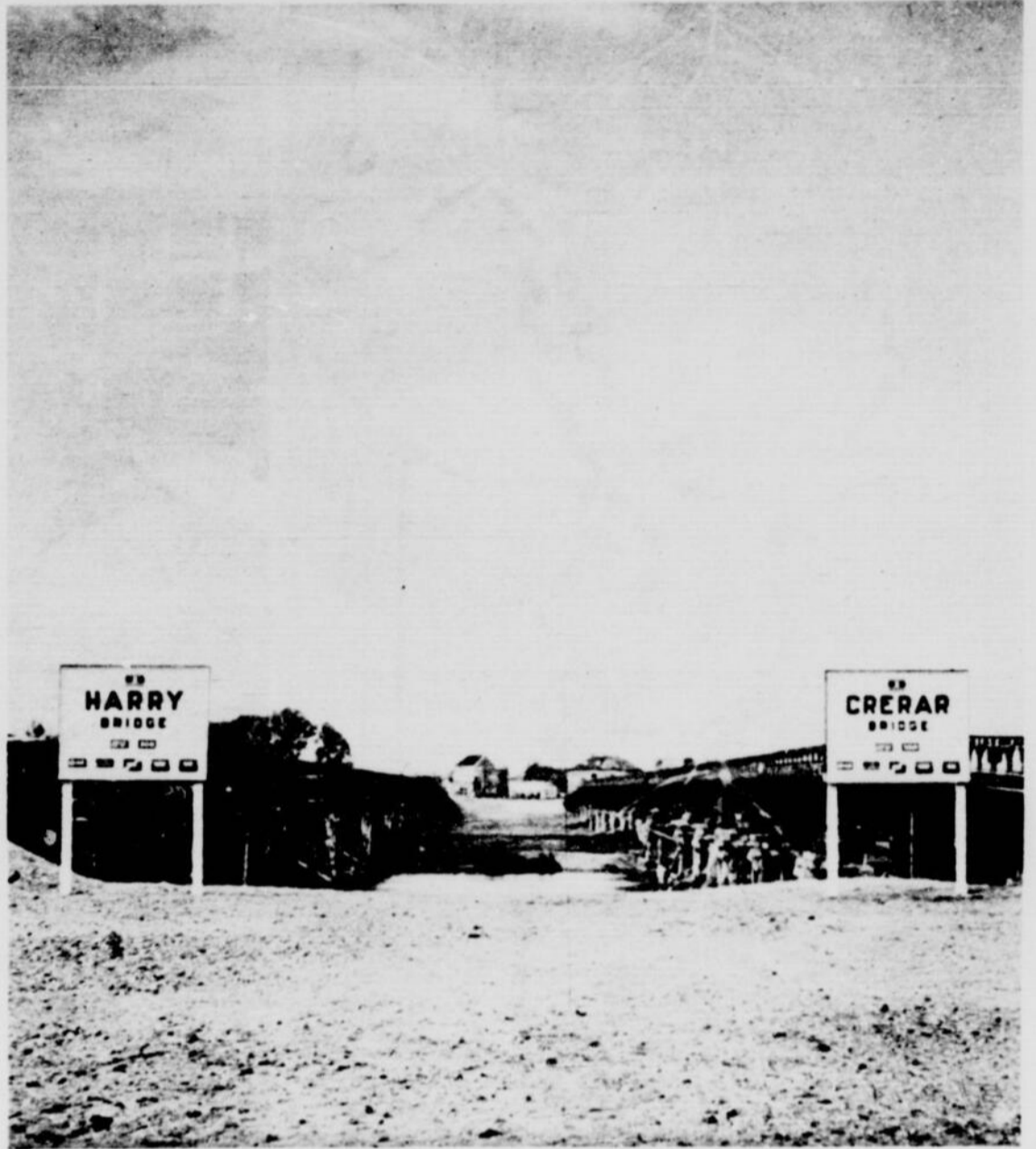
Les ingénieurs canadiens, qui ont construit ces deux ponts sur la rivière IJssel, en Hollande, leur ont donné les noms de "Harry" et de "Crerar" en l'honneur du commandant de l'armée canadienne, le général H. D. G. Crerar. Ces deux ponts mesurent environ 1,500 pieds de longueur et ils ont été construits en moins d'un mois. (Photo de l'armée canadienne outre-mer).
