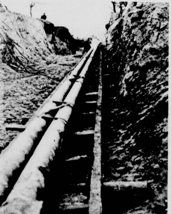
Une pipeline de 300 milles de longueur, franchissant la Manche pour traverser ensuite la France, la Belgique, la Hollande et enfin le Rhin jusqu'en Allemagne, a permis d'alimenter en essence les armées alliées. D'un débit de 48,000 gallons à l'heure, cette conduite a été installée par les corps de génie canadien et britannique. Dans la photo du haut de la page, on voit la partie verticale d'une conduite en "U" permettant de franchir un canal de Belgique sans nuire à la navigation. Dans la photo du centre, on voit les poutres d'appui de la conduite que l'on a déposée sur le lit du canal. Enfin, dans la photo du bas de la page, on voit une section de la pipeline installée dans une tranchée en Belgique. (Photos de l'armée canadienne outre-mer).
