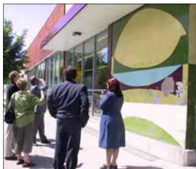
Avant intervention Photo 6 : Métro-Richelieu
