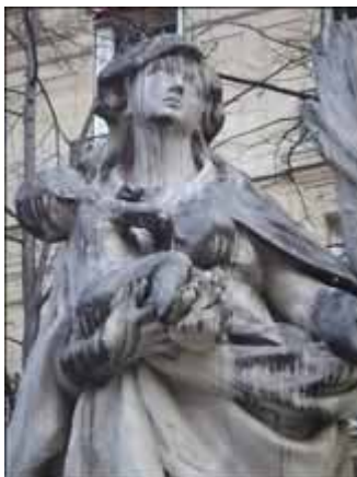
Cette sculpture, constamment ombragée, est tachée par les algues formées sur les zones de ruissellement de l'eau
