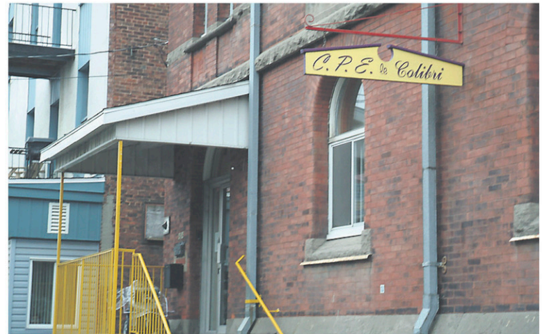
Le conseil d'administration du Colibri signale que les travaux à faire sont tellement majeurs qu'il plaide pour la construction d'un nouveau bâtiment — PHOTO JANICK MAROIS, ARCHIVES LA VOIX DE L'EST
