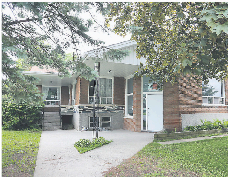
La Maison des Jeunes des Quatre Lieux a réussi à réunir les sommes nécessaires à la réalisation des importants travaux de rénovation de la résidence qu'elle occupe à l'angle des rues St-Michel et Union. — PHOTO ALAIN DION
