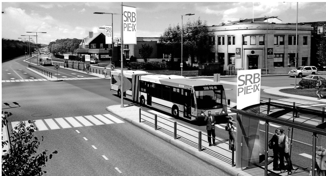
Les travaux débiteront dès l'automne à Montréal-Nord.
