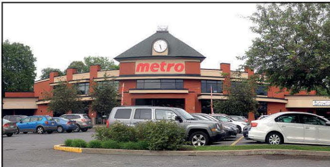
Le marché J.-C. Messier de la Place Metro fut construit en 1967 et récemment rénové en 2017.
