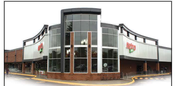
Construit en 1980, le supermarché Place Metro Sabrevois a subi une cure de rajeunissement en 2014.
