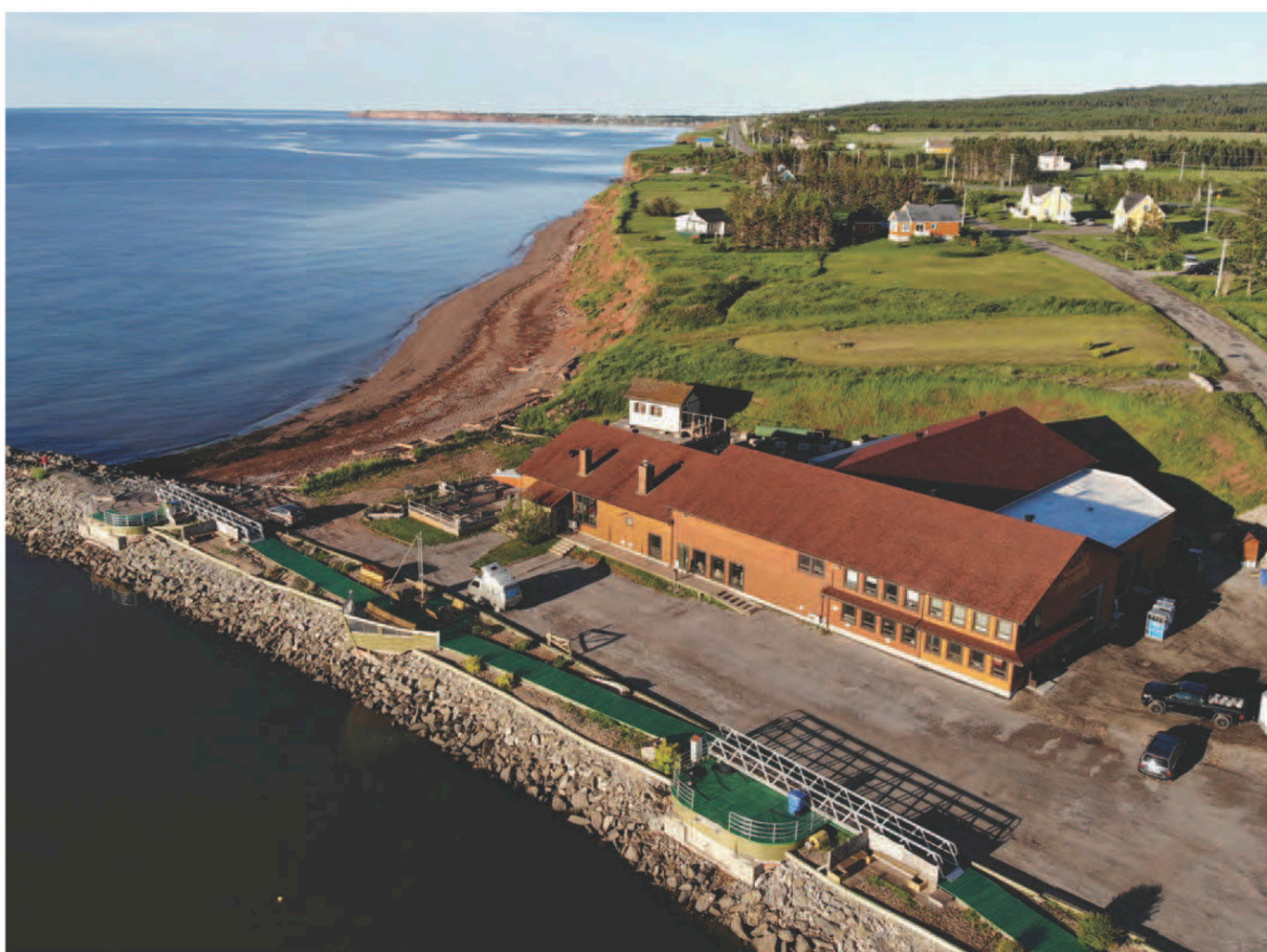
Les pieds dans le golfe du Saint-Laurent, la microbrasserie Pit Caribou, à L'Anse-à-Beaufils, près de Percé. C'est dans la petite cabane blanche derrière le bâtiment principal que se trouve le fameux coolship où démarre la fermentation spontanée.
