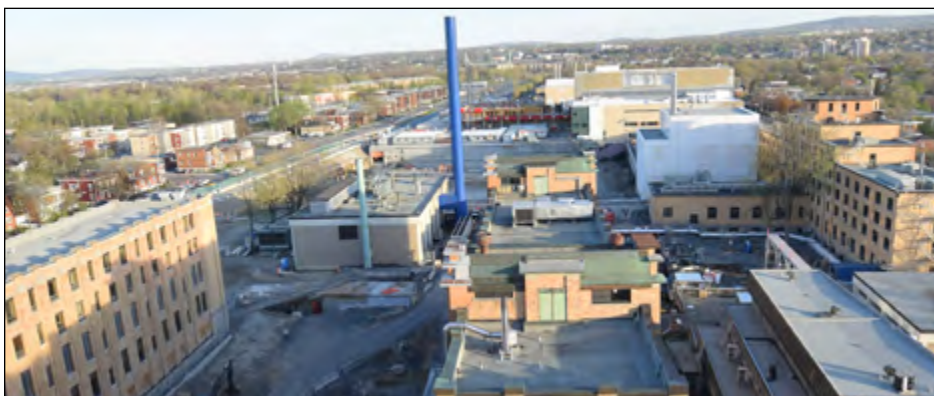
Les travaux de construction ont recommencé sur l'ensemble du site de l'HEJ le 11 mai dernier.
