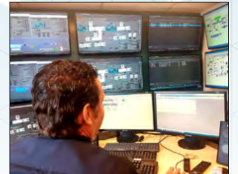
Depuis le 23 mars, les équipes de la Direction des services techniques ont entamé l'activation des deux nouveaux bâtiments.
