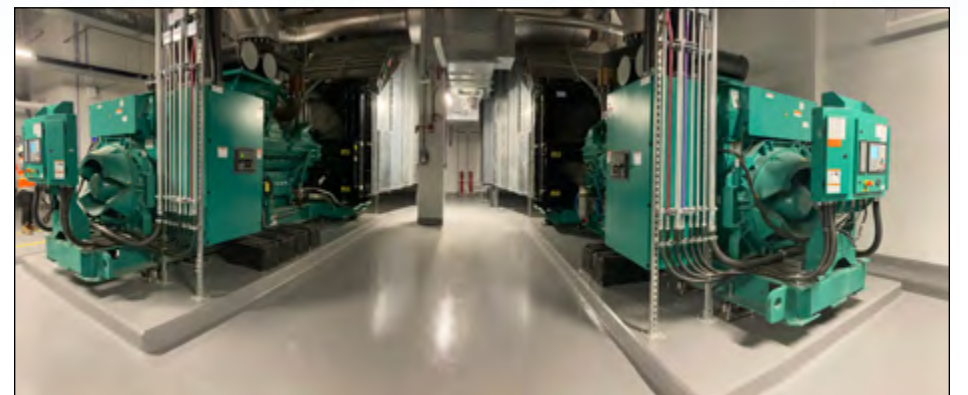
Nos nouvelles génératrices, d'une capacité de 2 mégawatts chacune, permettent d'assurer l'approvisionnement d'urgence en électricité.
