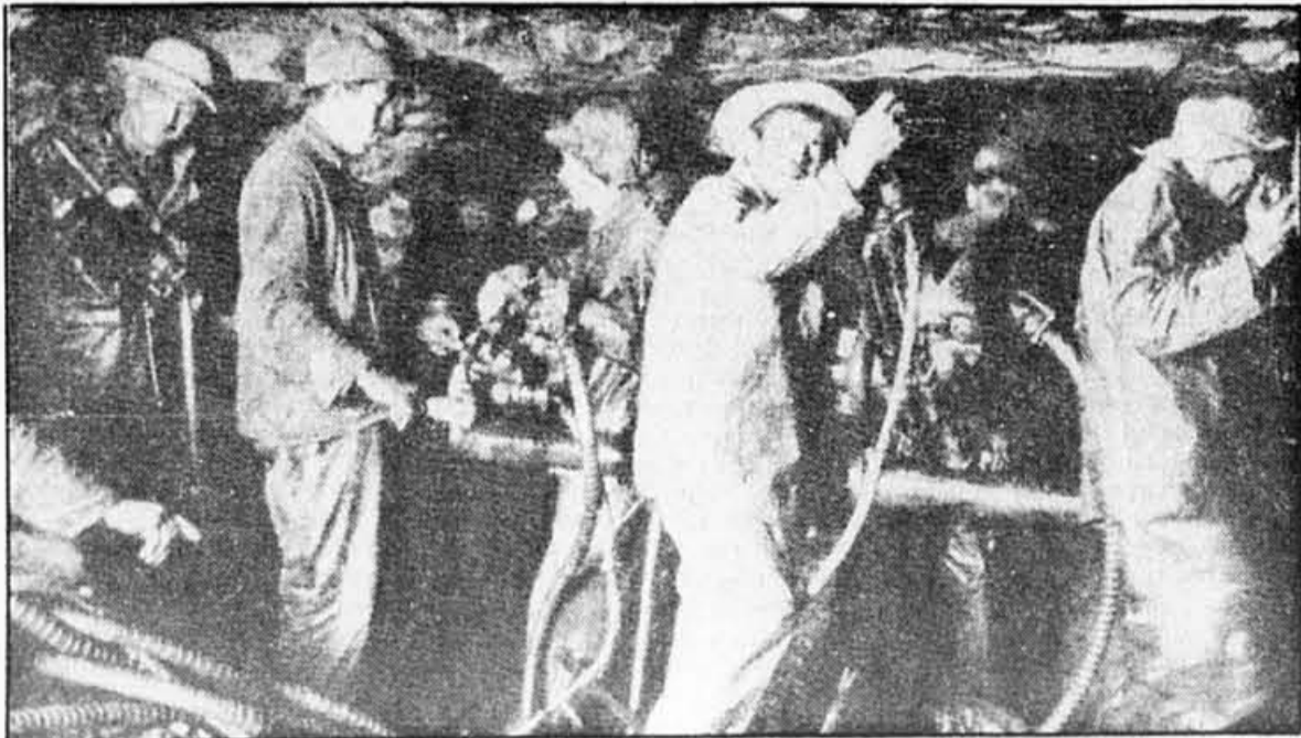
Les taupes du tunnel à l'oeuvre
