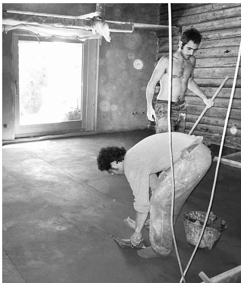
L'installation d'un plancher de terre représente un gros défi. Il faut notamment compter entre un et deux mois pour le séchage.
