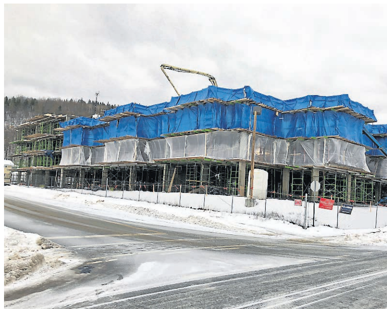
La construction va bon train pour la résidence des Bâtisseurs à La Tuque. —PHOTO: AUDREY TREMBLAY.
