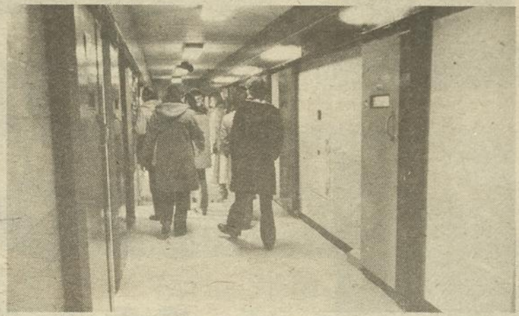
Les "wings" ne sont pas larges. Les portes glissent fort heureusement sur leurs rails afin de gagner de l'espace et éviter les angles morts et les "recoins favorables aux mauvais coups". Les portés se verrouillent du poste de contrôle central favorisant un contrôle constant de la population.
