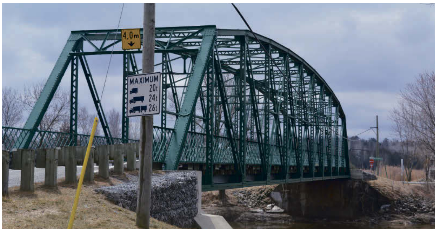
Le pont Provost d'Acton Vale sera bientôt ouvert de nouveau à la circulation. Les travaux de réparation seront effectués jusqu'à la fin octobre.
