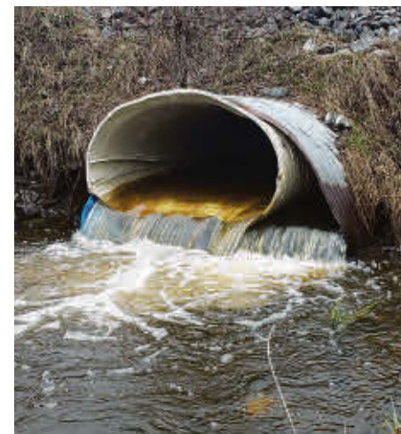
Dans les derniers mois, le MTQ a procédé au gainage du ponceau et l'a renforcé avec du béton. Photo Alexandre Brouillard | Les 2 Rives ©
