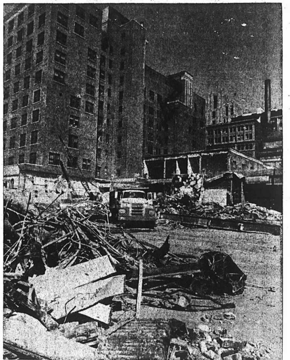
Depuis une semaine, les démolisseurs n'épargnent rien dans la partie arrière du Terminus Craig.
