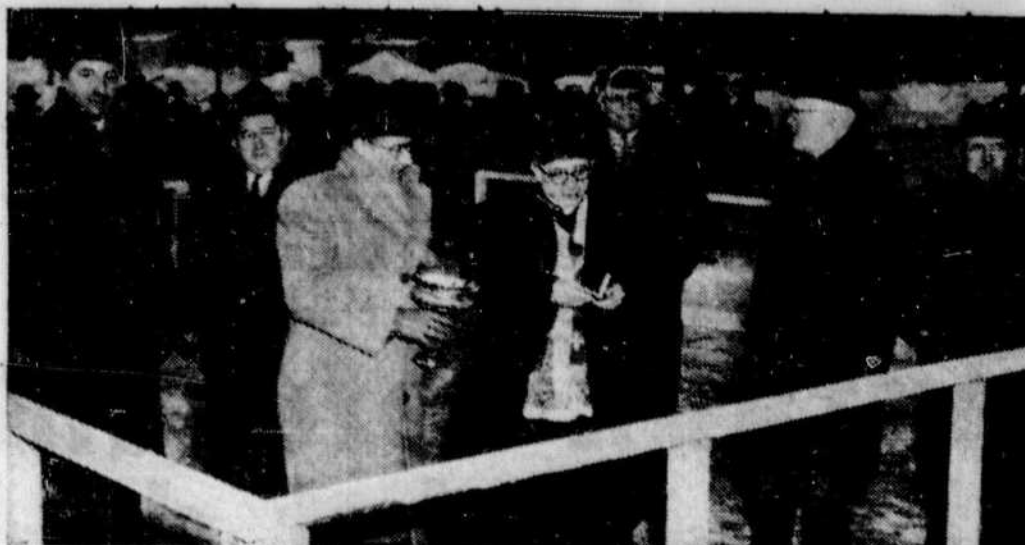
USINE DE $10,000,000 A CONTRECŒUR — Le curé de la paroisse Très-Sainte-Trinité de Contrecoeur M. l'abbé A. Legendre a béni samedi après-midi les travaux de construction de la nouvelle usine que Steel Company of Canada fait ériger à cet endroit. Ce sera la fabrique de tuyaux la plus moderne au Canada et construction coûtera $10,000,000. Sur cette photo, on reconnaît de gauche à droite MM. S. Layton, gérant des usines Stelco de Montréal, C. Ladouceur, député provincial de Verchères, W. Piché, maire de Contrecoeur, le curé Legendre, MM. S. Amour, conseiller économique de Stelco, H.W. Mawhinney, vice-président de la compagnie, et G. Duhamel, maire de la paroisse de Contrecoeur.
