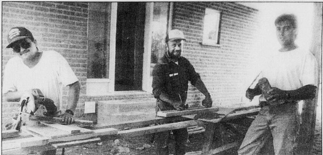
VACANCES - C'est fini le temps où les travailleurs de la construction se retrouvaient tous en vacances pendant les deux dernières semaines de juillet... et cela, en raison des conséquences de la loi 142.
