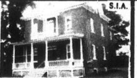
27-29-31 Montfette Victoriaville • 3 logements
