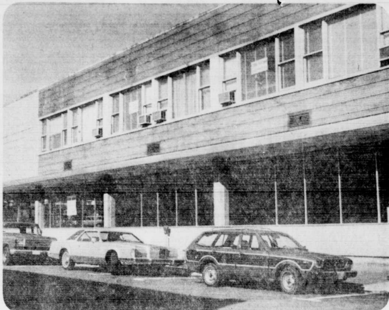
L'ancien édifice qui logeait la chaîne d'alimentation Steinberg sur la 5e avenue, à Shawinigan, sera occupé, en février 1978 par la succursale de la Banque provinciale du Canada. Grâce à cette décision de reloger ces services
