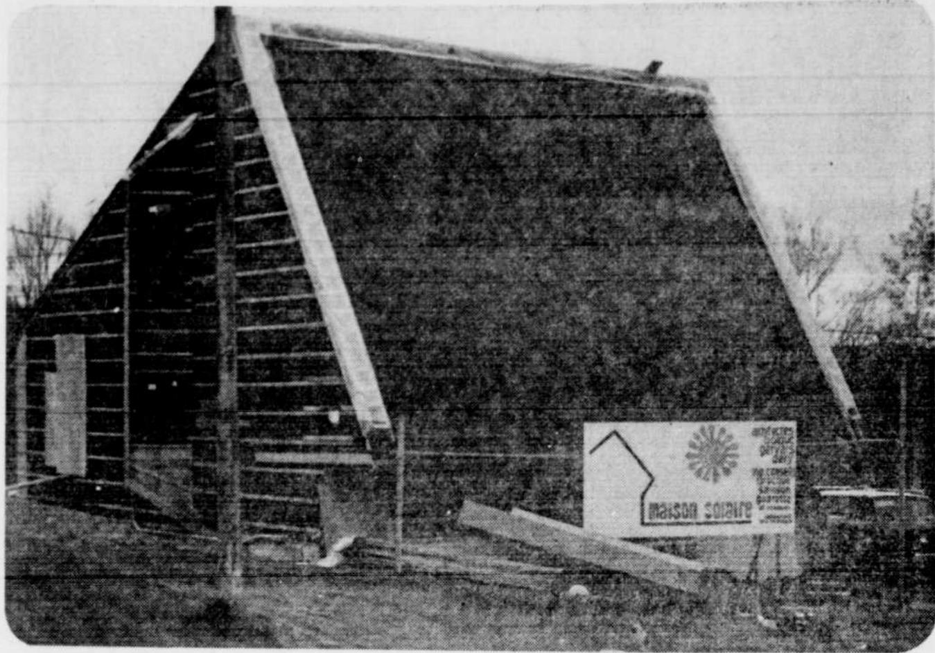
La première maison solaire en Mauricie, un rêve de l'architecte Roland Gervais.
