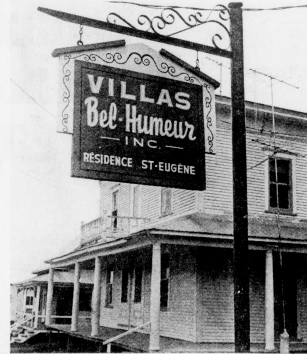
C'est un véritable nid à feu cette Villa Bel-Humeur de Saint-Eugène. L'escalier de sauvetage a été condamné ainsi que tout l'établissement par le ministère du Travail en 1969. Mais après cinq ans il y a toujours des pensionnaires. (Photo Bo-Soleil)
