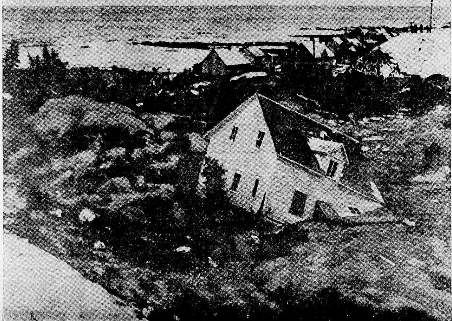
LES EBOLIS DE LA GASPELIE — Voici une des huit maisons qui ont été démolies dans le glissement de terrain à St-Joachim-de-Tourelle. Elle est entourée d'une rivière de boue qui l'a presque entraînée dans le St-Laurent.
