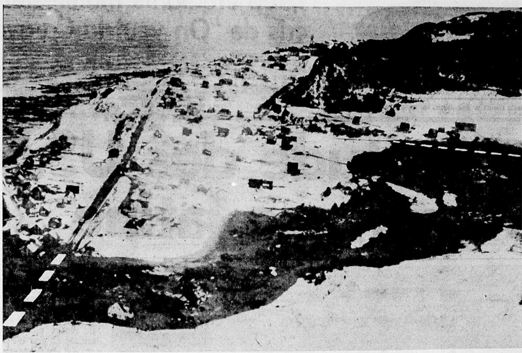
LE DESASTRE DE ST-JOACHIM DE TOURELLE — Dans un tronçon de route, huit maisons, un camion et une automobile. Quatre personnes ont perdu la vie.
