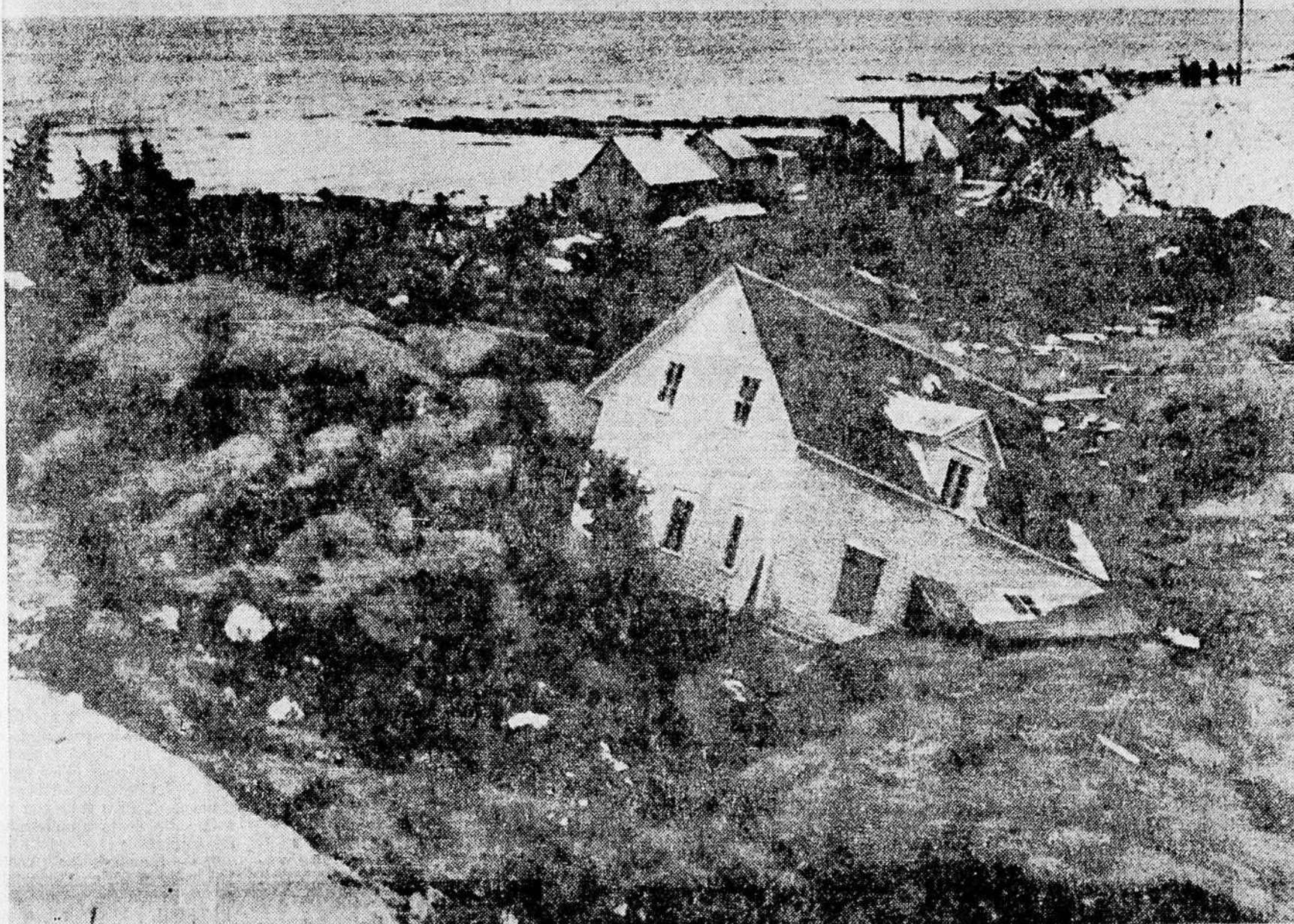
LES ÉBOULIS DE LA GASPEISIE — Voici une des huit maisons Tourelle. Elle est entourée d'une rivière de boue qui la presque entraînée dans le St-Laurent. (Téléphoto PC)
