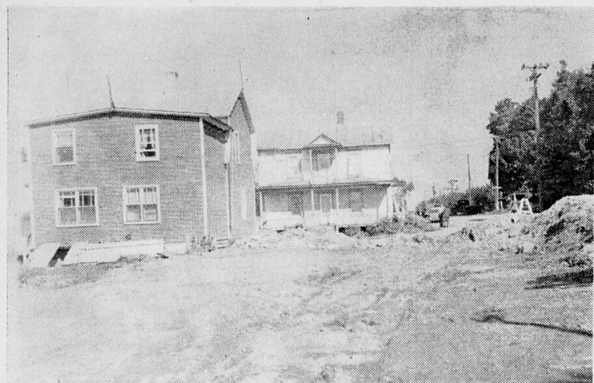
Voici un aperçu de la nouvelle route que l'on est en train de construire et qui sera le boulevard de Ste-Marie lorsqu'elle sera terminée. On démonte présentement des maisons pour faire place à la route. Ce sont des gros travaux que l'on effectue présentement et cha-
