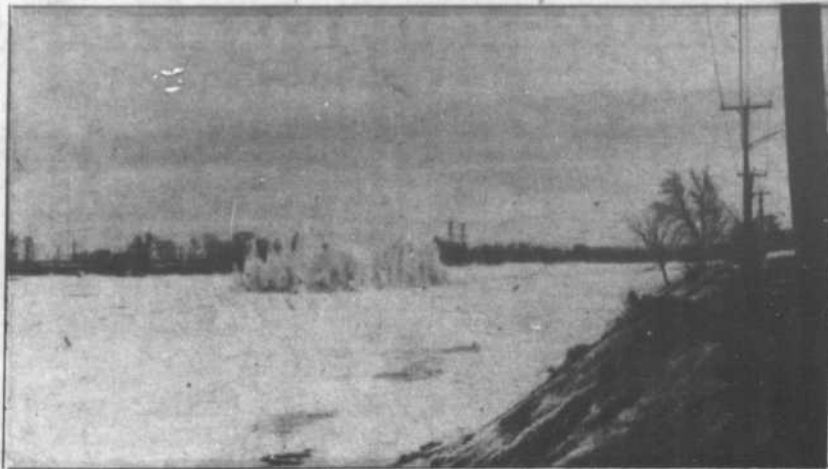
"Baboum-m-m..." lirait-on dans une série de bande dessinée. Les maîtres dynamiteurs viennent de déclencher leur troisième explosion de la journée et le couvercle de glace de la rivière vient d'en prendre un sérieux coup, facilitant d'autant le travail mécanique du dégel et réduisant les risques de crues. (Photo, LA REVUE)
