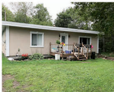
St-Colomban, 6, rue Boucher
