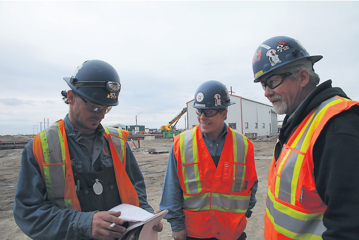
Des travailleurs discutent sur le chantier du projet Boundary Dam. Lourdemment subventionné, il reste controversé, en raison notamment de son utilité pour l'industrie pétrolière.
